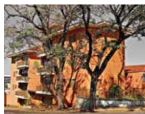
O PRIMEIRO EMPREENDIMENTO DA COPEMA
